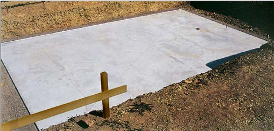
zur Lunkerfreiheit verdichten, mit einem Gartenrechen verteilen und mit einer Kardätsche abziehen.
